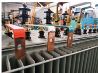
Mantenimiento de transformadores
