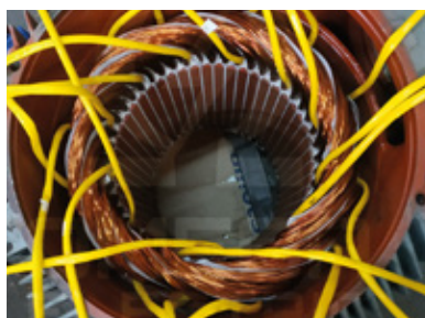
Rebobinado de motores trifásicos
